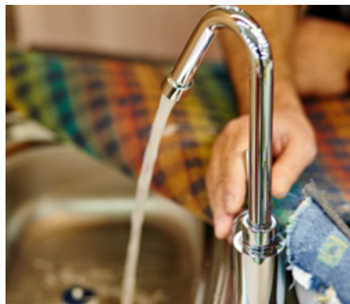
Corretta installazione degli impianti idraulici.
