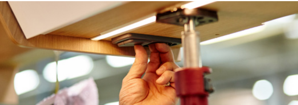
Verifica del funzionamento e corretta installazione degli impianti elettrici.
